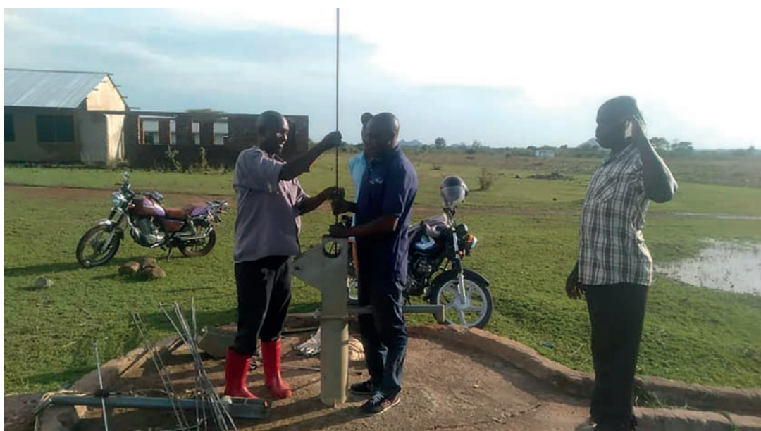
Riparazione pozzo manuale vicino la scuola
