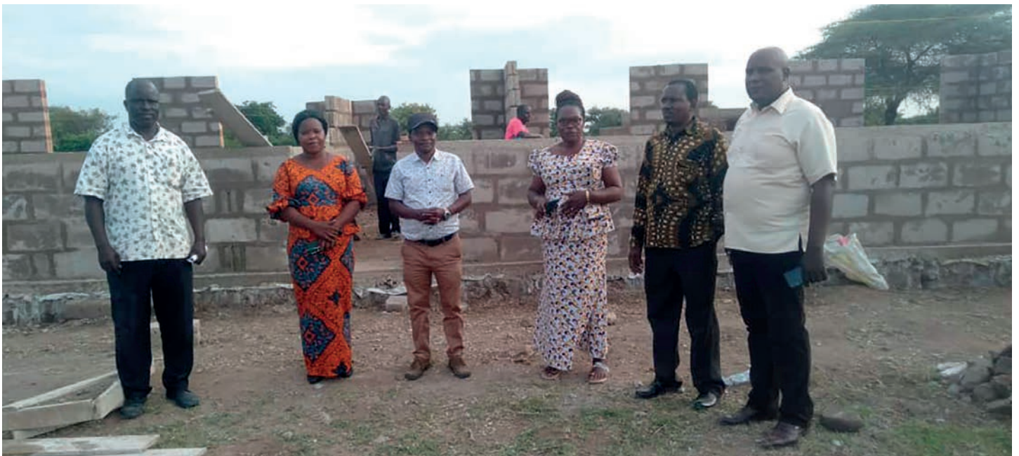
I responsabili dell'Educazione del Distretto visitano i lavori in corso
